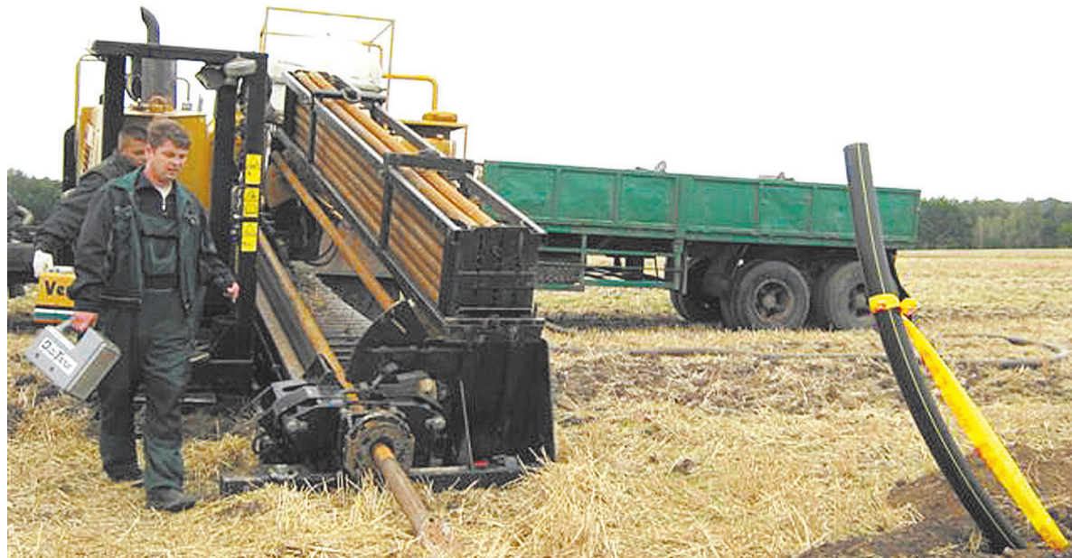
Строительство межпоселкового газопровода Малые Пруды Лазаревское Новосильского района по программе ОАО «Газпром» «Газификация регионов РФ».
